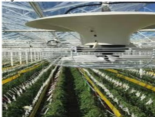
Рисунок 11. Циркуляционная вентиляция
